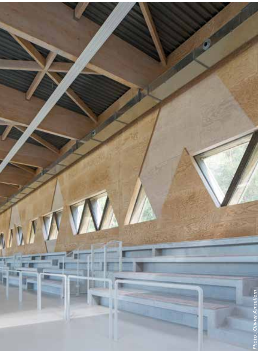
▲ À l'intérieur, les parties pleines de la façade ont été réalisées avec des murs à ossature bois, préfabriqués et isolés en atelier.
