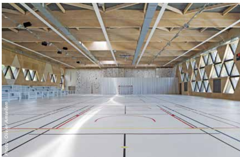
▲ Les arbalétriers de 30 m de portée, en lamellé-collé de Douglas, relient les deux façades en pin laricio.
