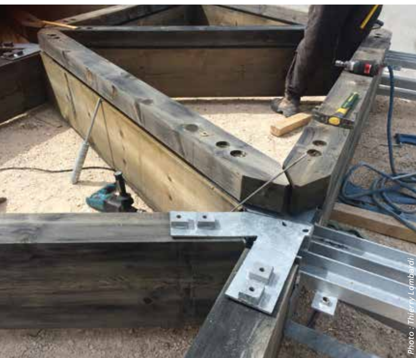
▲ Détail d'assemblage de la résille.
