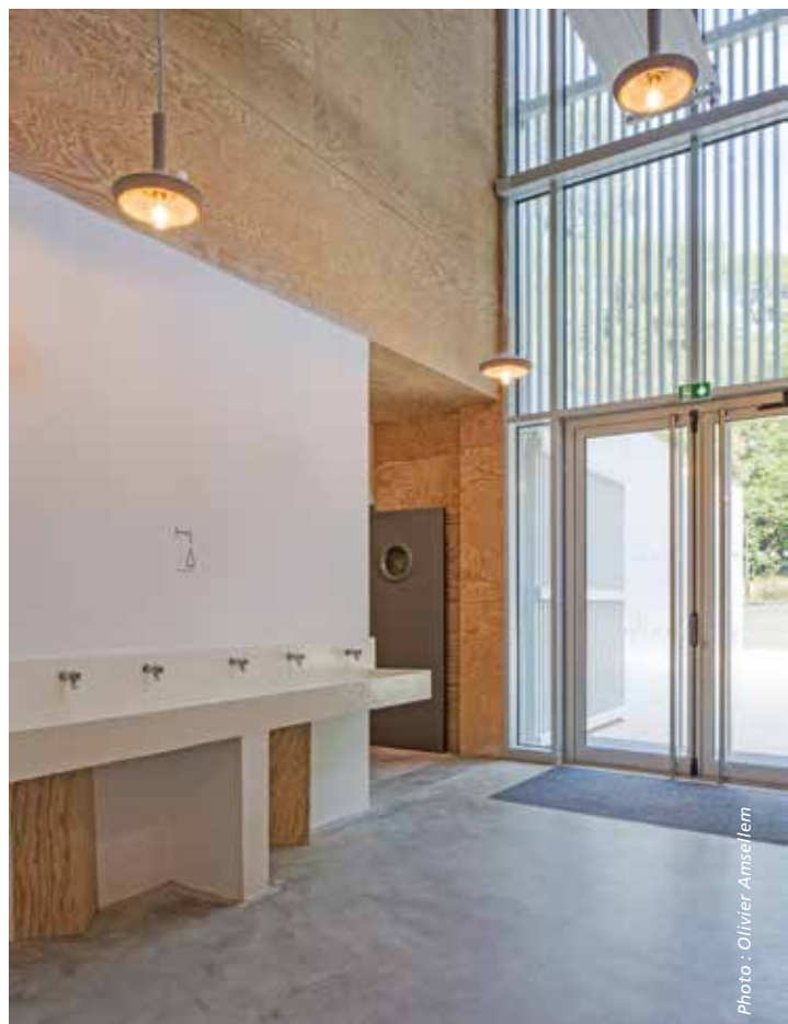
Le contreplaqué de pin maritime a été utilisé pour l'habillage de murs intérieurs.
